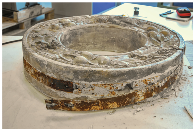
6. kép. A korrodálódott vaspánt eltávolítása
