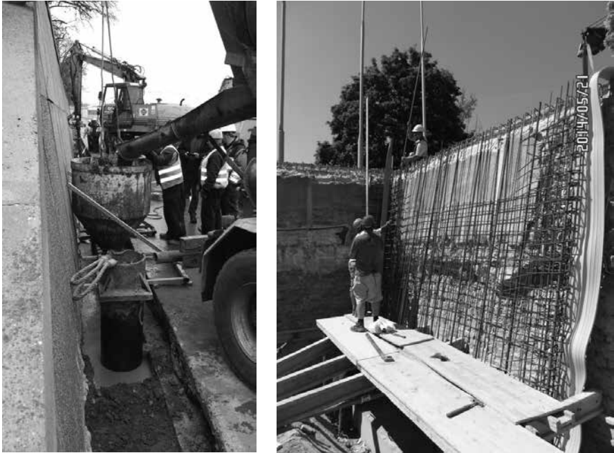
1. kép A résfal és a köpenyfal építése (Forrás: ATIVIZIG)
