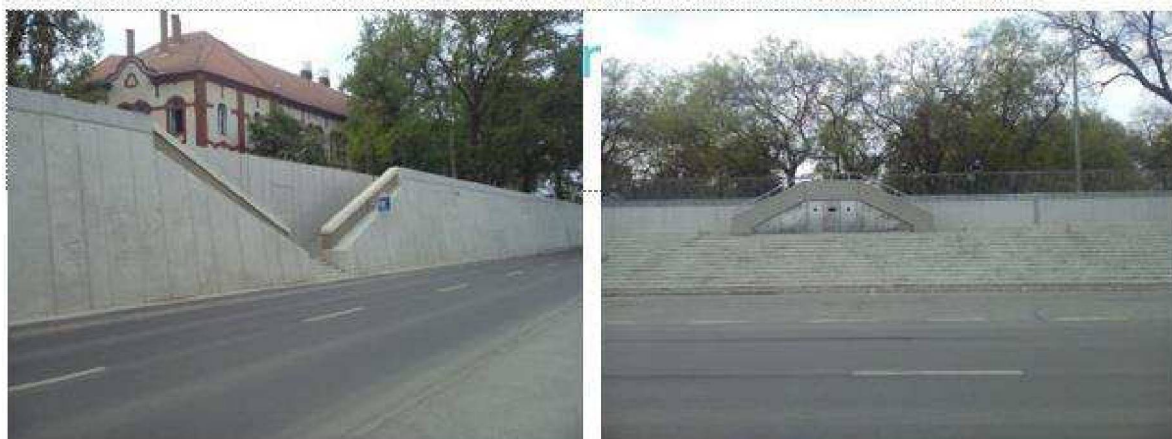
4. ábra: A szegedi partfal és a rakparti lépcsősor a felújítás után
