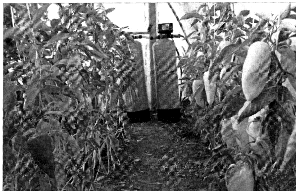
1. KÉP Alkalmazott kéttornyos cérium-hidroxid arzénszűrő berendezés (fotó: Lantos, 2013).
